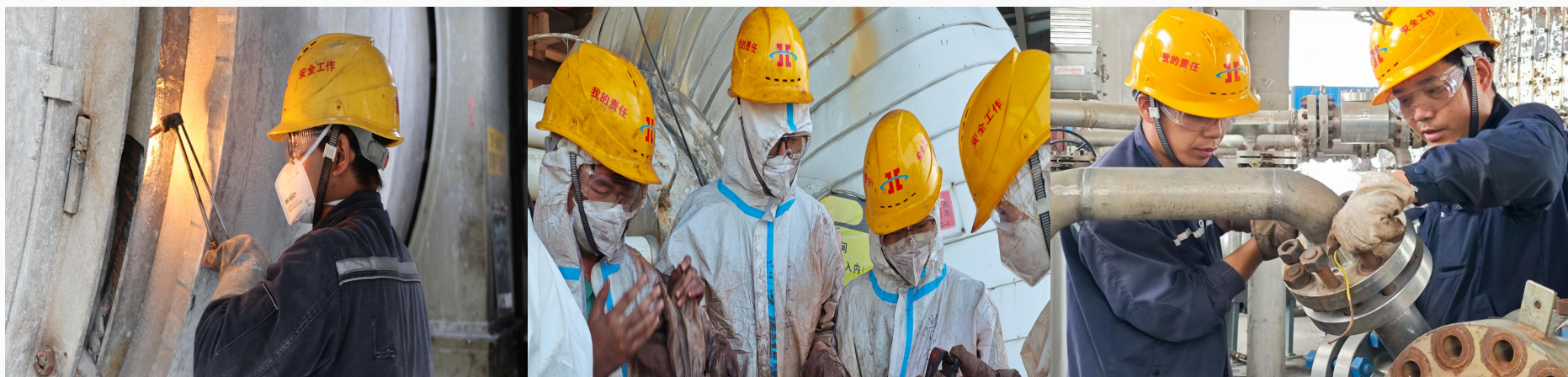
河南基地檢修現場
